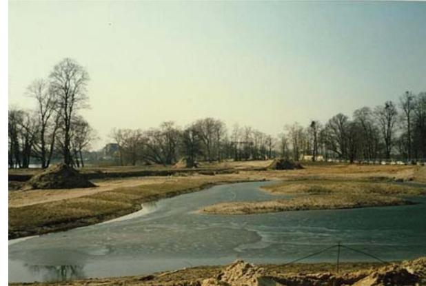
Teichanlage im Bau mit der Feinkonturierung der Ufer und der Inseln
