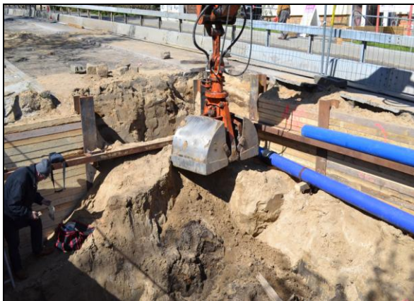
Verbau Bereich 1. Blickrichtung nach Nordwesten (links)
