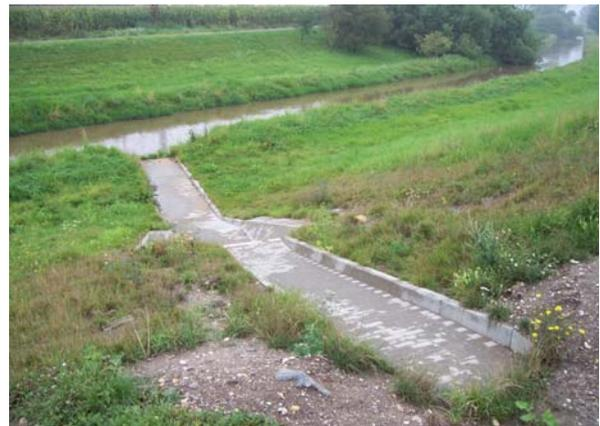
Das Gelände wird komplett durch große Versickerungsmulden und mit einem System offener, in Fahr- oder Wegebereichen gedeckter Entwässerungsrinnen als Überlauf in die Pleiße von Regenwasser entsorgt.
